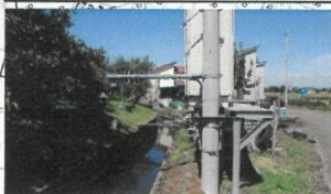
第18分水工 (水位データ遠方監視 ・警報装置)
