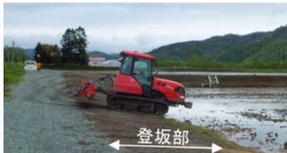
ターン農道の整備
