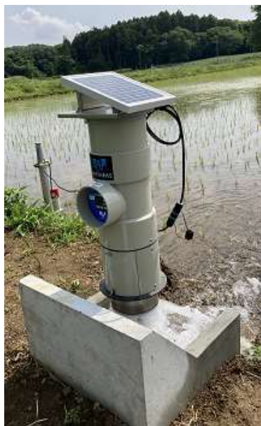
パイプラインでの給水
