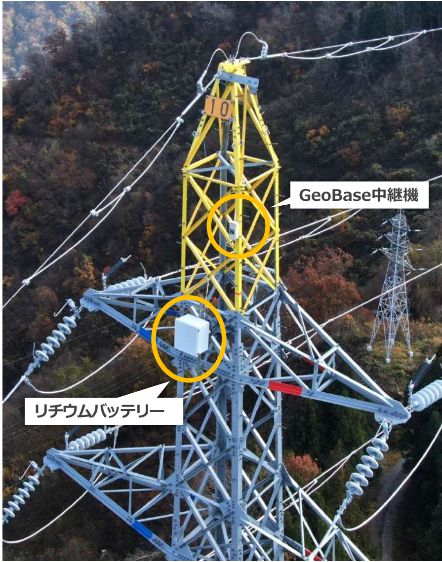
GeoBase Multi 中継機を送電鉄塔に設置（上記は同じ設置場所を別アングルでドローン撮影）
