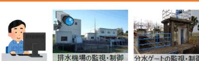
排水機場の監視・制御
