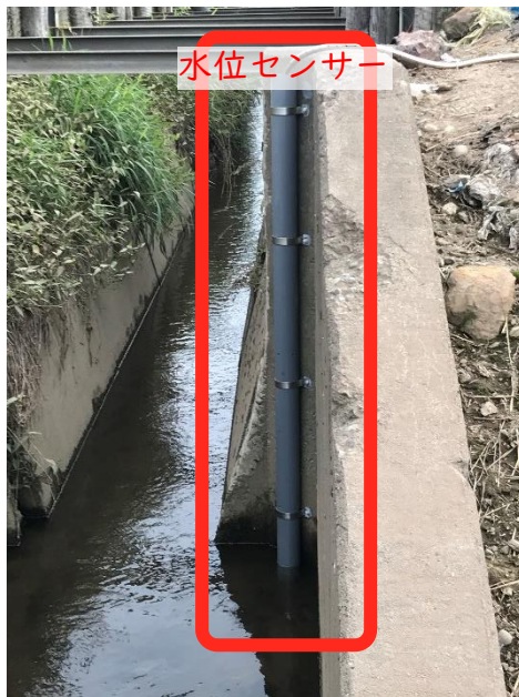
用水路への水位センサーの設置
