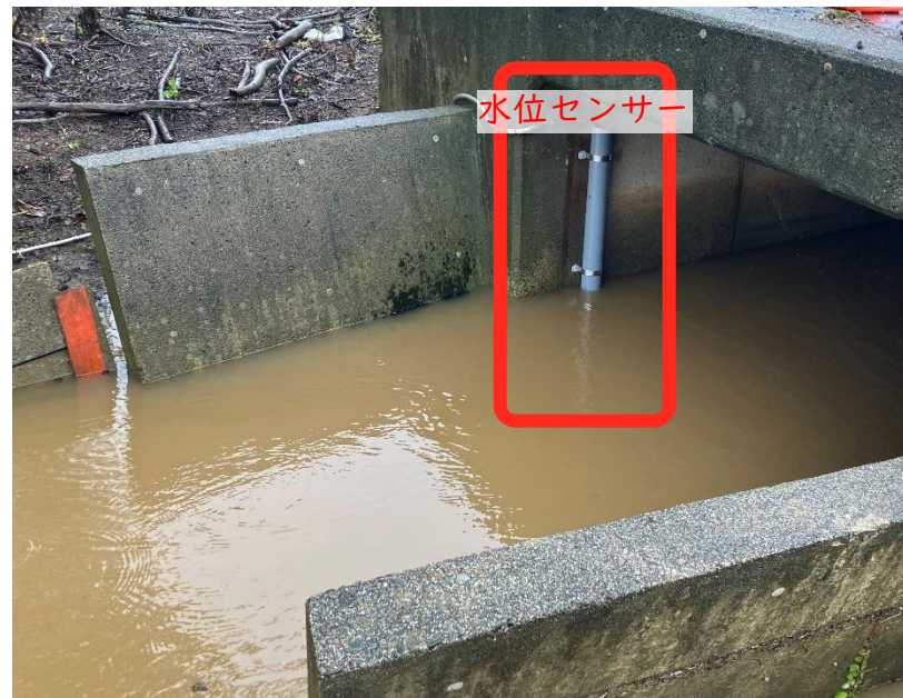
用水路への水位センサーの設置
