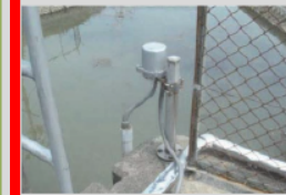
水位計の設置
