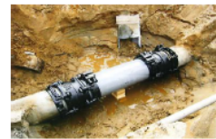
漏水防止のための整備
