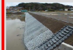
ため池護岸の整備
