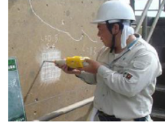
老朽化した施設の機能診断
