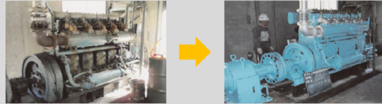
原動機の分解補修、塗装
