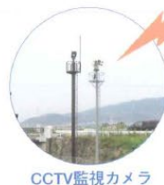
CCTV監視カメラ
