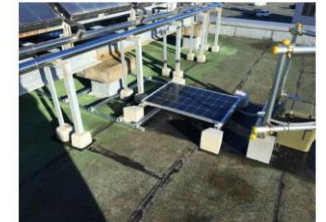
既存基礎への固定状況
