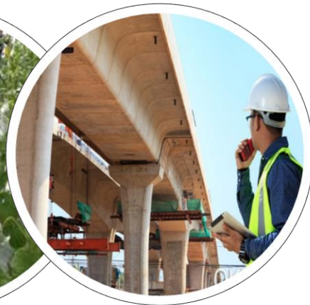
インフラの監視
