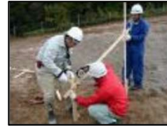
設計図に合わせて 丁張り設置・施工
