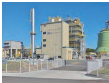
バイオマスプラント
