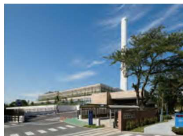
ごみ焼却発電施設
