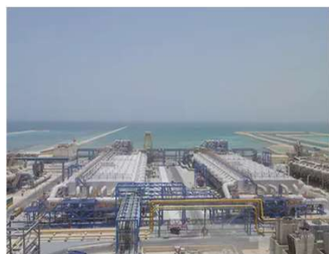
海水淡水化プラント (カタール)
