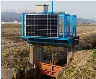
リモート排水ゲート
