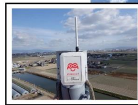
無線基地局(LPWA)は携帯電話基地局の中に設置見通しがよく1台で広い範囲をカバー
