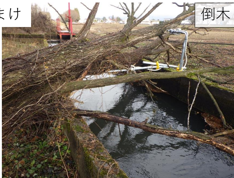
倒木撤去・水位計復旧作業中
