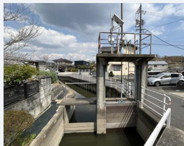
遠隔電動装置（開度監視）
