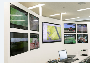
5G/LTE等を用いた 監視制御
