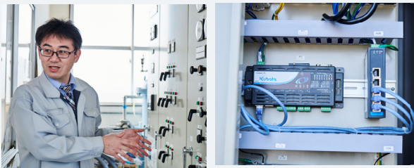
揚水ポンプ自動制御システム （既存手動システムに後付けで遠隔機能を付加）
