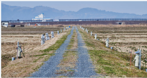
自動給水栓（本体）
